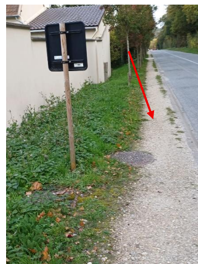
ABSENCE DE TROTTOIR STABILISE
