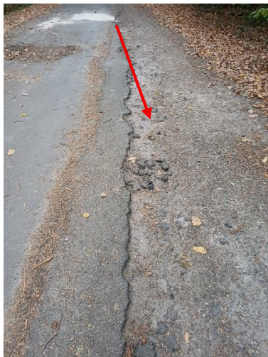
ABAISSMENT DE LA CHAUSSEE (RTE DE LA VIGNERIE)
