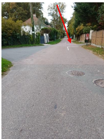
STOP MAL PLACE (RTE DE LA VIGNERIE)
