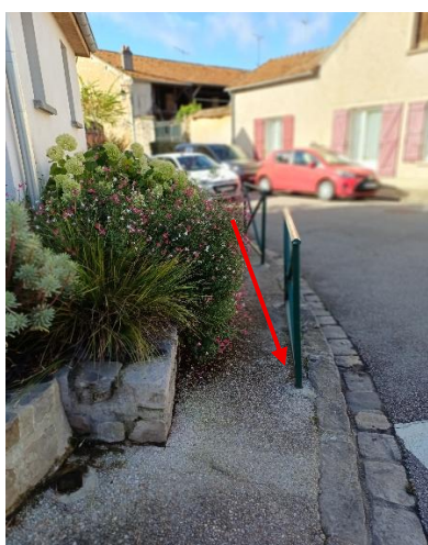
REMBARDE GENERANT UN RETRECISSEMENT DU TROTTOIR (RUE DE LA HARPE)
