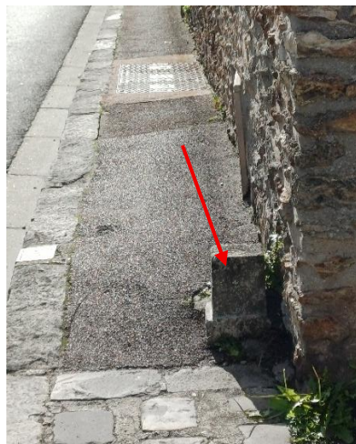
BORNE EN PAVE (RUE DE LA MAIRIE)
